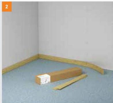
2 Upevnění okrajových izolačních pásek
