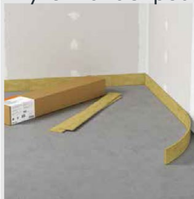
Upevnění okrajových izolačních pásek
