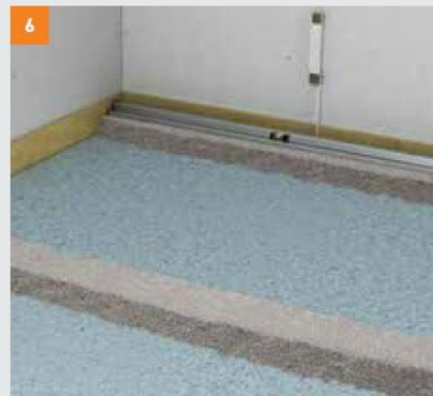
6 Dále se připraví druhý běh, který bude výškově odpovídat prvnímu
