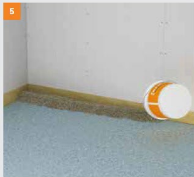
5 Připraví se první běh pro stahovací lat
