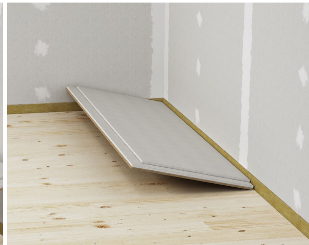
3. Pokládka podlahových prvků fermacell®
