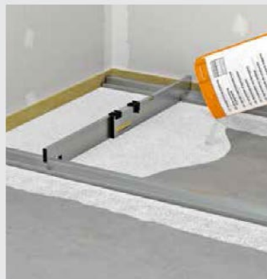
Aplikace vyrovnávacího podsypu
