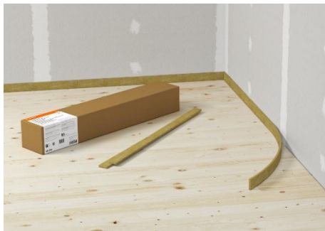
Instalace okrajové izolační pásky
