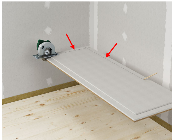
2. Uříznutí polodrážky první řady podlahových prvků fermacell®
