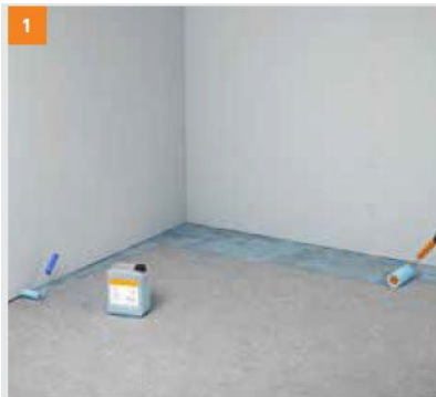
1 Penetrace podkladu hlubkovou penetrací fermacell
