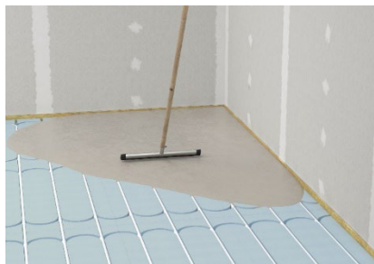
Zalítí prvků fermacell® Therm25 lepící maltou fermacell™
