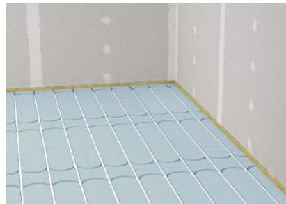
Instalace topných trubek podlahového topení 16 mm
