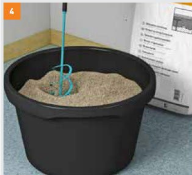
4 ... pomocí vhodného míchacího zařízení
